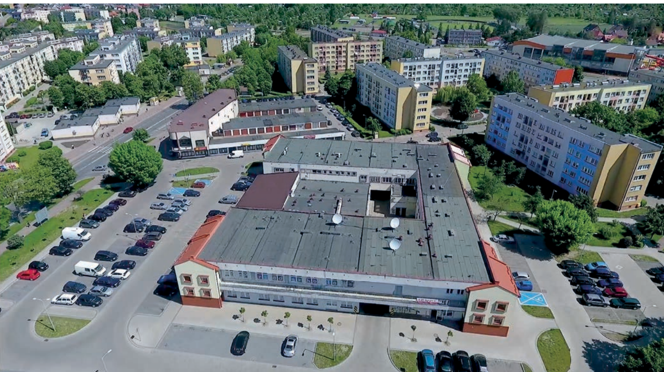
Siedziba Ostrołęckiej Spółdzielni Mieszkaniowej z nowo wybudowanym parkingiem.
