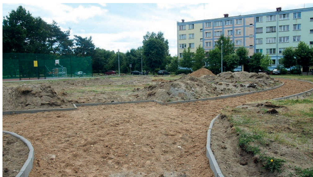
Boisko w budowie na osiedlu H. Modrzejewskiej.
