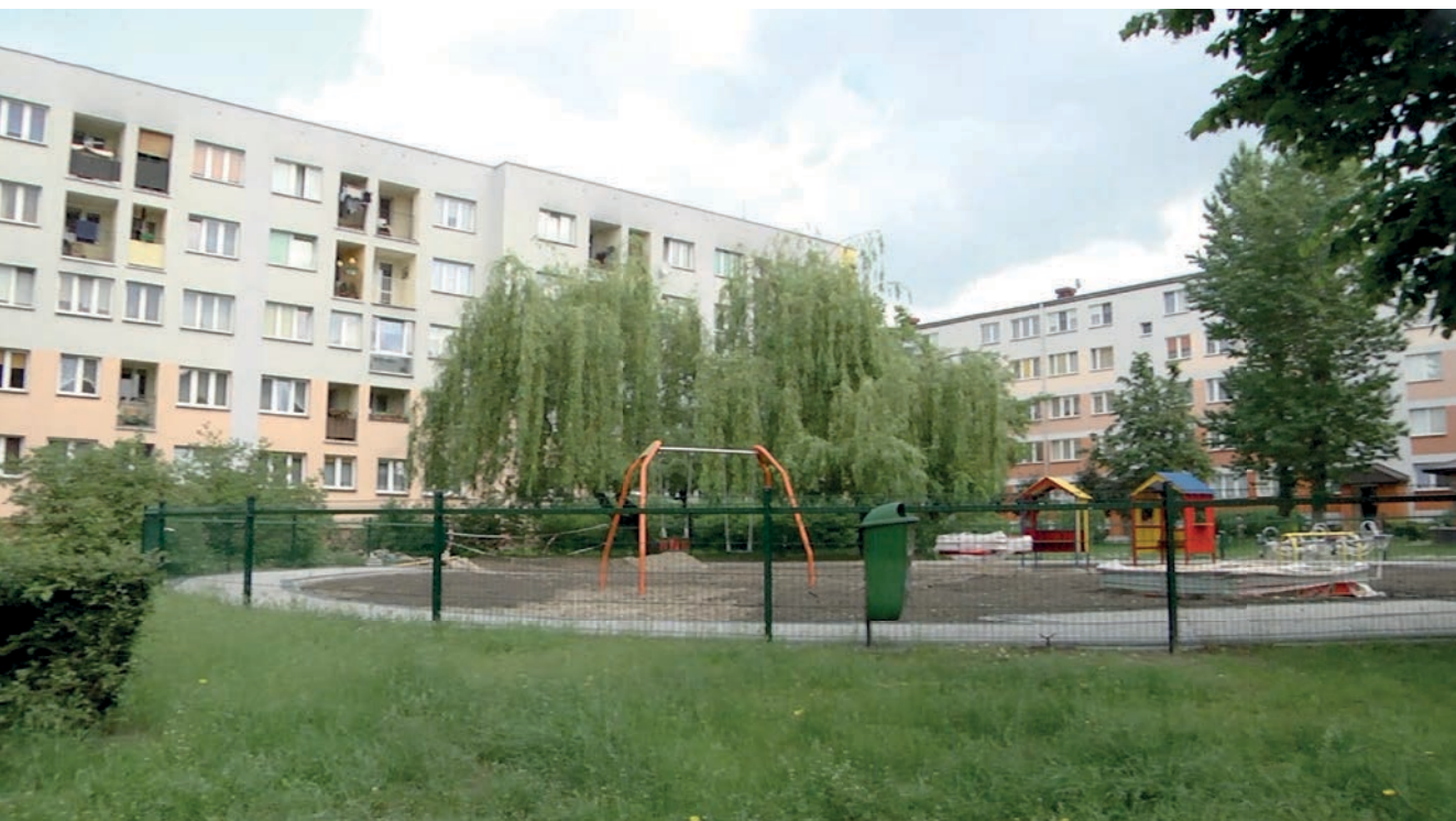
Plac zabaw w budowie na osiedlu gen. J. Hallera.
