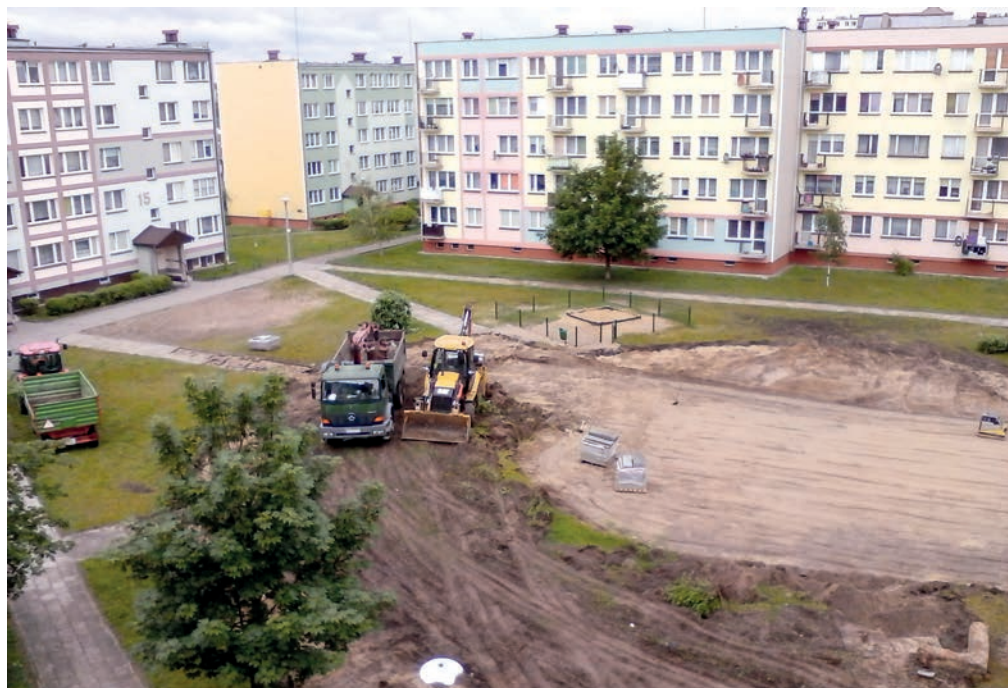
Boisko w budowie na osiedlu Goworowska.
